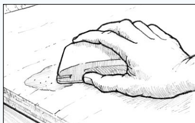
Figur 23 Slipa spacklet jämnt med omgivande yta.
